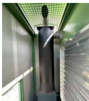
Industrie-Schalldämpfer innenliegend sowie elektrische Abluftklappe serienmäßig
