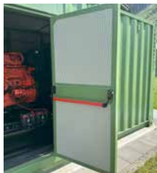
Große Zugangstür auf beiden Längsseiten mit Panikbeschlag
