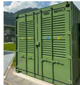
2-flügelige Wartungs- und Zugangstüren vorne mit Zuluftöffnung
