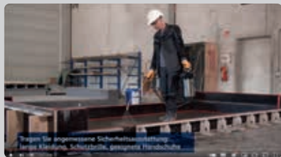
Anwendung von Betontrennmitteln
