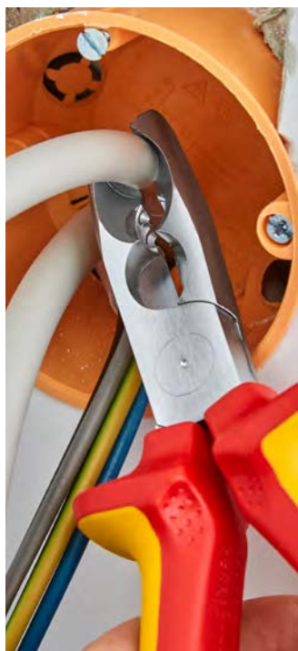
Abmanteln tief unten in der Unterputzdose
