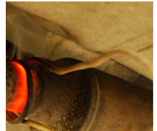
› Zum Lösen von schwer zugänglichen Teilen durch den Einsatz von speziellem Wickeldraht
